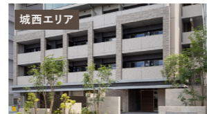
城西エリア ■フレンチア高円寺北 東京都中野区大和町1-66-1
