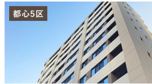
都心5区 ■フレンチア築地 東京都中央区築地6-12-1
