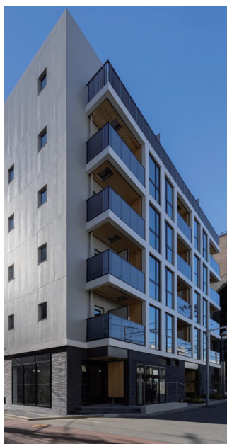
フレンシア青葉台 (2024年竣工・21戸／店舗1区画)
